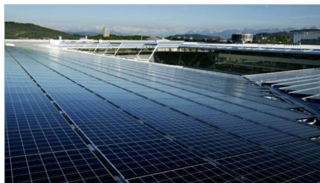
для монтажа солнечных батарей
