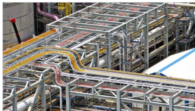
для монтажа кабельных трасс
