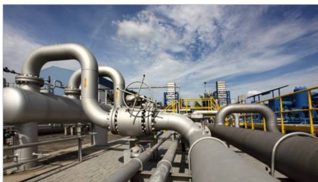
для монтажа трубопроводов
